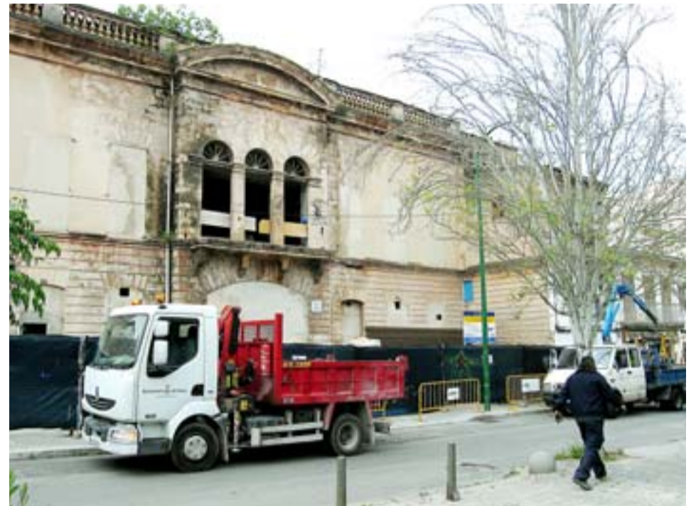
Operarios con camiones y grúas han empezado los trabajos de rehabilitación del teatro.
