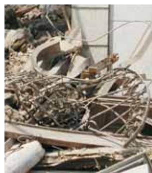
Les llindes de pedra granítica van a parar a contenidors de runa, i les excavadores transformen les baranes de ferro forjat en ferralla recargolada
