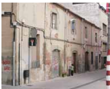
Cases del segle XVIII al carrer Concepció en estat de degradació
