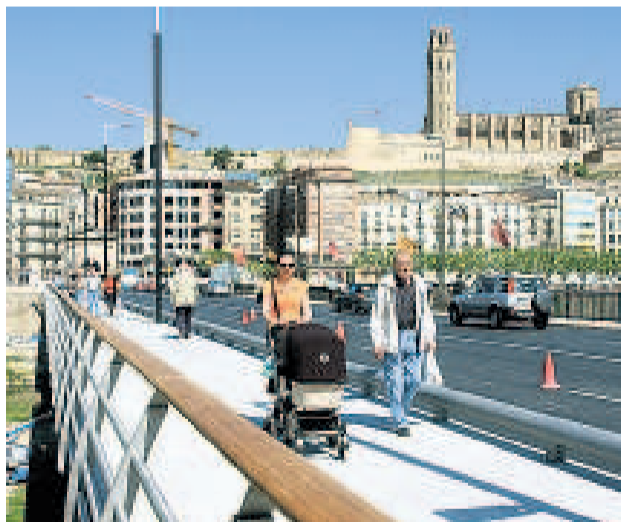
Imatge de la vorera del Pont Vell ja rehabilitada. L. DELSHAMS
