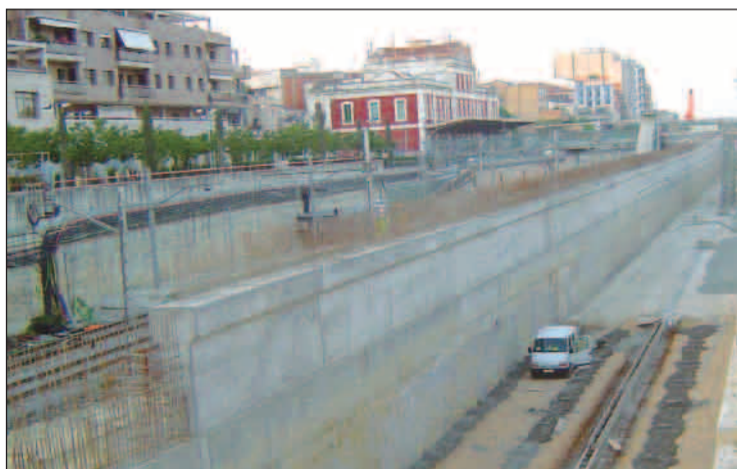
Obres de soterrament i cobriment de les vies del TGV. Foto: 7dies.net
