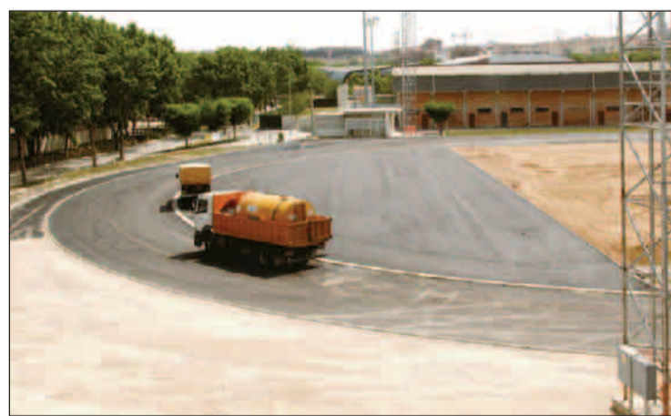
Les obres de la nova pista d'atletisme avancen a bon ritme. Foto: 7dies.net
