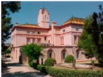
Residència de Llançà "edifici"
