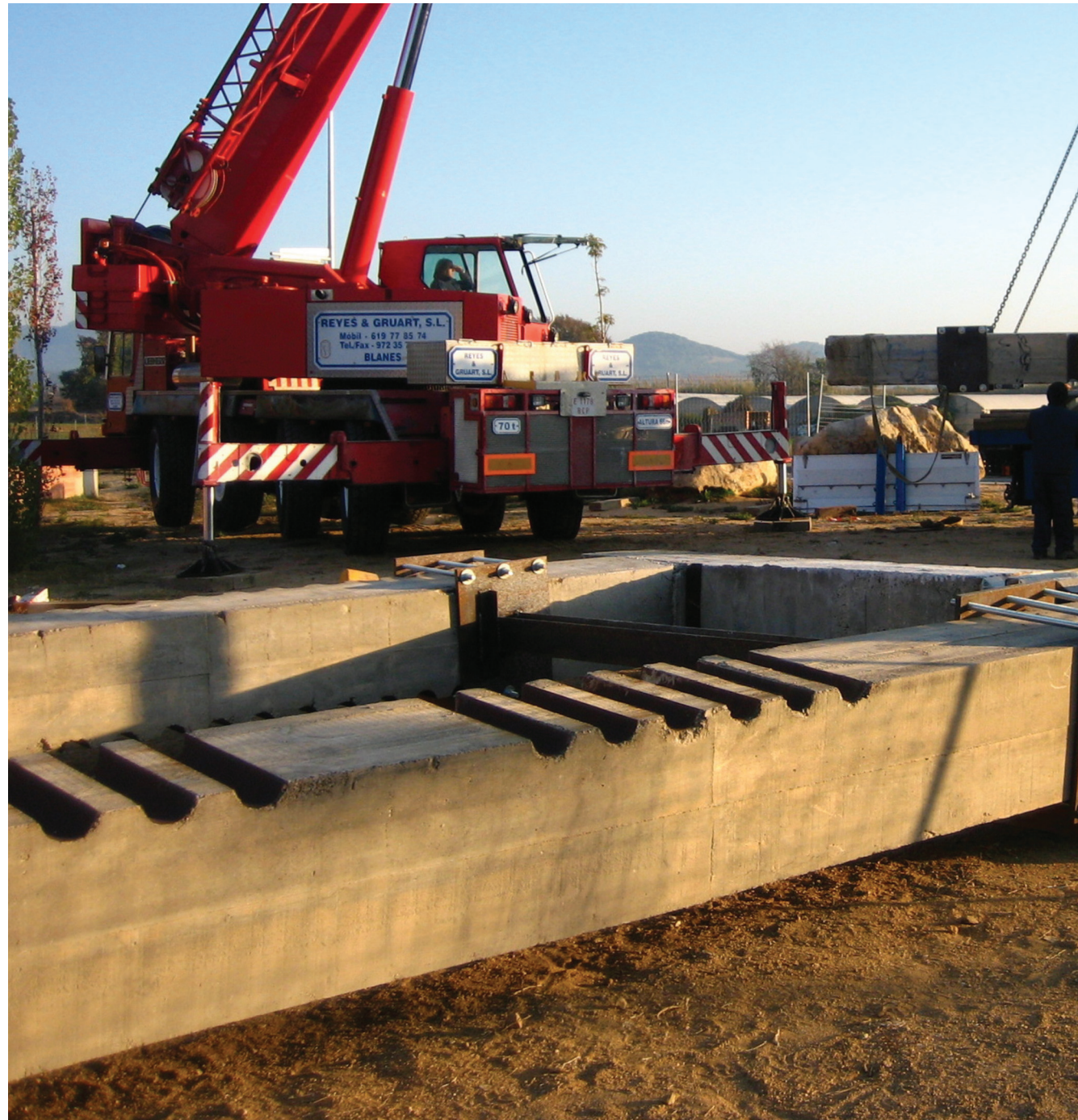
Trasllat de la Porta del Cel al Parc Fluvial de la Tordera
