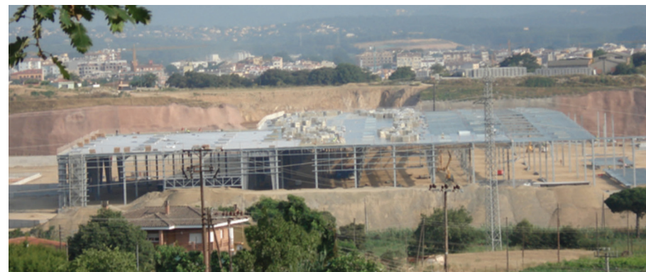
Obres del projecte Inditex
