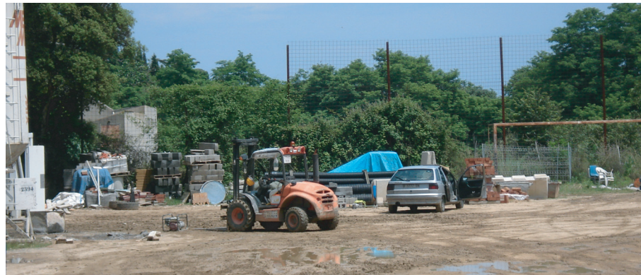
Obres de sanejament de la muntanya de Sant Genís de Palafolls
