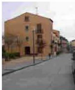
9.- Arranjament del carrer i la plaça de Joaquim Ruyra i Homs 10.000 euros
