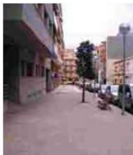
15.- Col·locació de més bancs i arbres al carrer de les Doedes 24.500 euros
