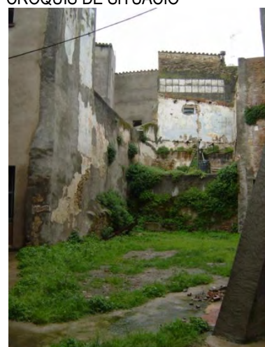
IMATGE ACTUAL DE L'INTERIOR D'ILLA
