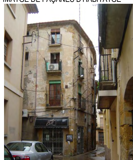
IMATGE DE FAÇANA A REHABILITAR
