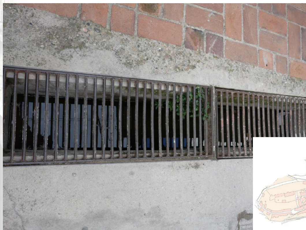
Il·lustració B10 Estancament d'aigües pluvials als embornals
