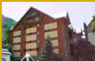
Residència de Llançà "edifici"
