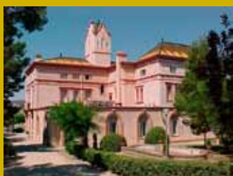
Residència de Llançà "edifici"
