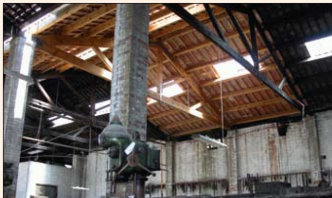
Primeres reparacions a la teulada de la històrica fàbrica
