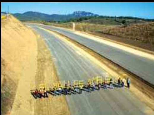
Un tram pràcticament acabat del Quart Cinturó a Terrassa, a tocar de Sant Miquel de Gonerres. La profunditat i amplitud de la ferida mostren quina és la dimensió de l'obra que el Ministerio de Fomento vol continuar en el terç nord de la plana del Vallès. El Vallès amb Quart Cinturó és així. Octubre de 2008. Autor: Lluís Brunet
