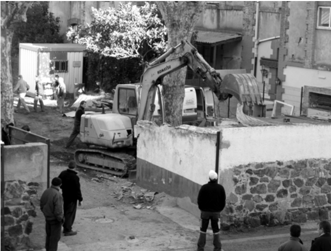
Començament de les obres de la planta d'osmosi inversa.
