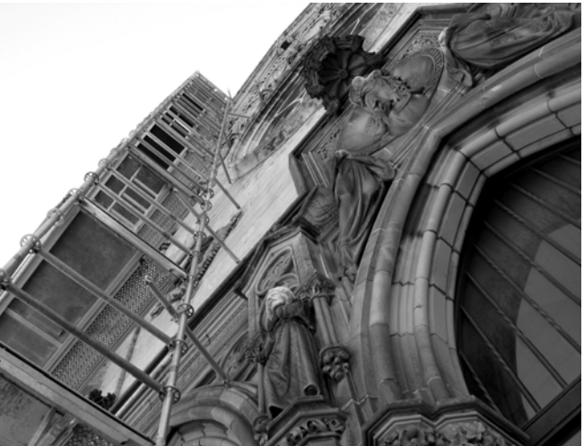
Obres de restauració de l'església de Santa Maria de Portbou
