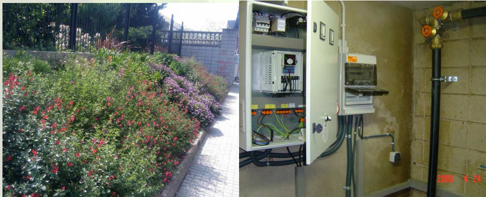
Recuperació del pou de l'estació d'autobusos per al reg del parc i creació d'un punt de recàrrega de neteja viària a Granollers centre. Font: Medi Ambient 2009
