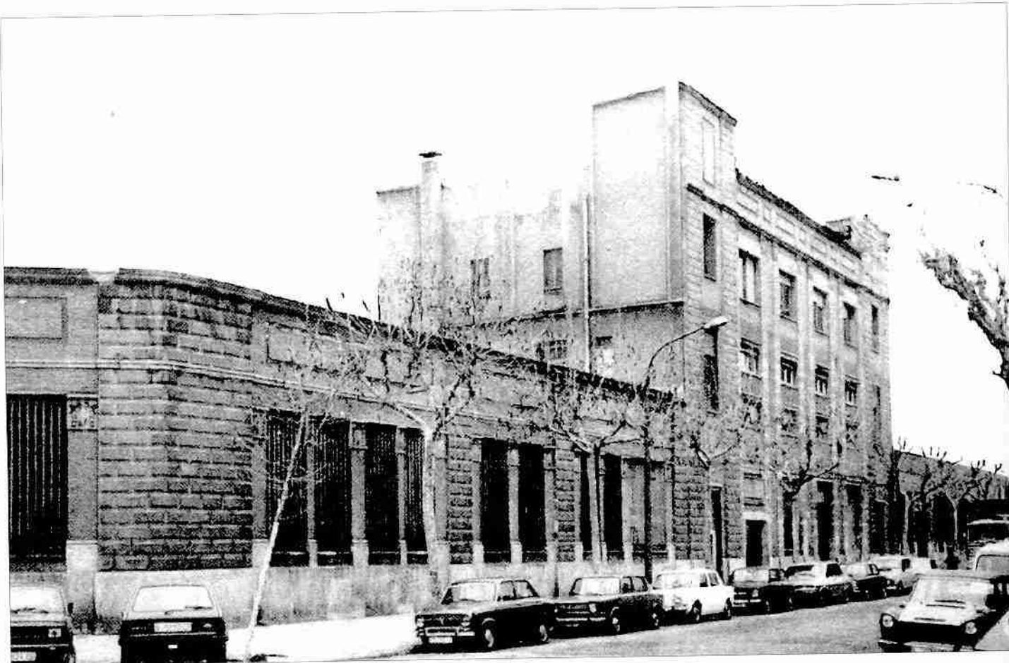
Façana d'Indústries Waldés del carrer Ramón Turró a inicis dels anys vuitanta.
