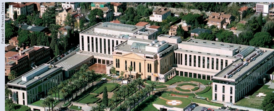
Instal·lacions de la Fundació Privada Teknon, a Barcelona.
