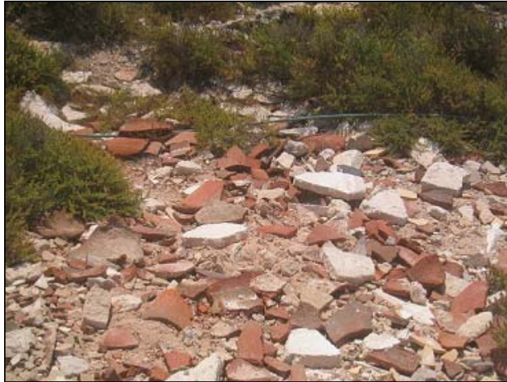
Fig. 23: Runes fruit del mal estat de les edificacions.
