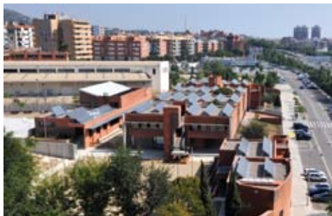
Plaques fotovoltaïques a l'Escola Montserrat de Sant Just Desvern
