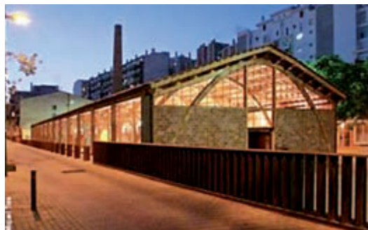
Nau gaudí de Mataró, equipament connectat amb fibra òptica a l'Anella Cultural (2010)
