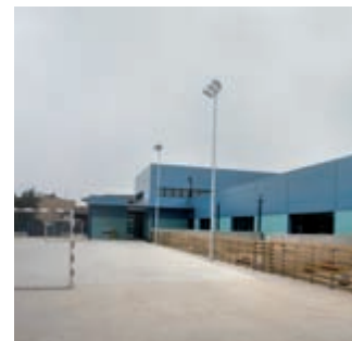
Reforma del Centre d'Educació Especial Mare de Déu del Pontarró Martorell (2008)
