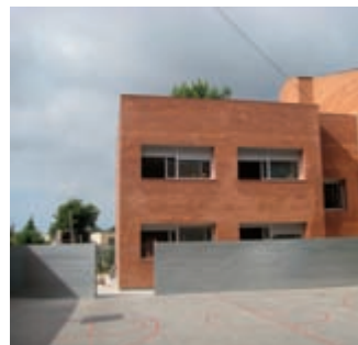
Ampliació de l'Institut Camps Blancs de Sant Boi de Llobregat (2008)
