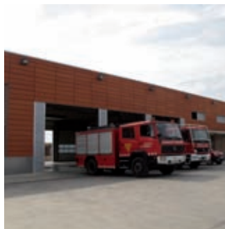
Construcció del Parc de Bombers de la Pera (2007)
