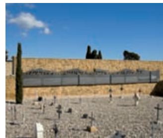
Fossa dignificada i senyalitzada de Tarragona
