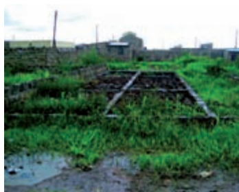
Construcció d'habitatges gràcies a un projecte de microcrèdits a Nairobi (Kènia) (2007-2009)
