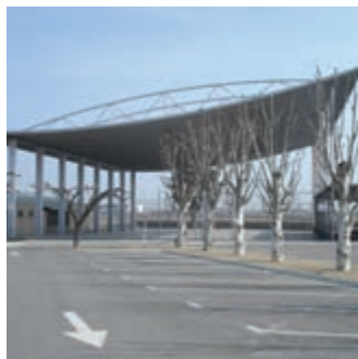
Coberta pista poliesportiva de Fondarella (Pla d'Urgell) finançada amb el PUOSC
