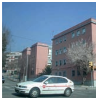
Rehabilitació de façanes al barri de Verdum de Barcelona (2006)
