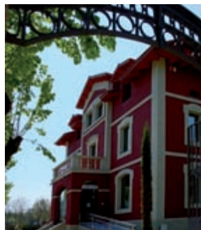
Millora a les colònies industrials del Ter i el Freser (Osona i Ripollès)
