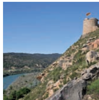
Programa de barris Rehabilitació del patrimoni històric de Flix (Ribera d'Ebre)
