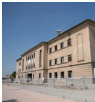
Obres de la nova seu del DAR a Gardeny (2010)
