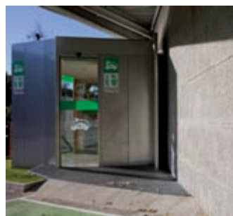
Punt de càrrega de vehicles elèctrics
