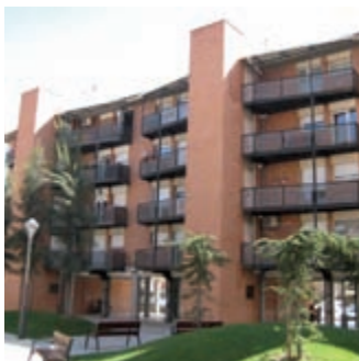
Instal·lació d'ascensors al barri de Buenos Aires de Sabadell
