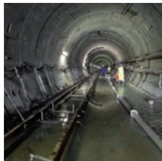
Galeria de la connexió Fontsa-Trintat a Horta (2008)
