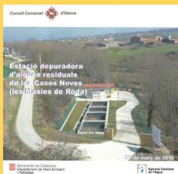
Imatge de l'Estació depuradora d'aigües residuals de les Cases Noves
