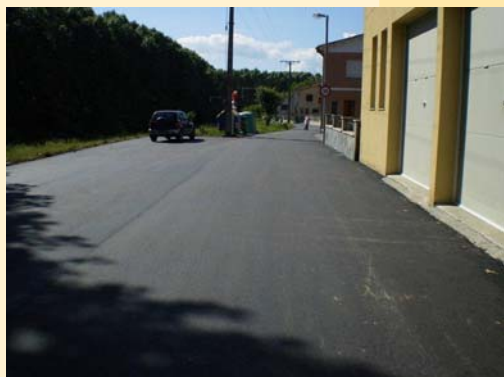
La carretera de Còdol després de les obres de millora.
