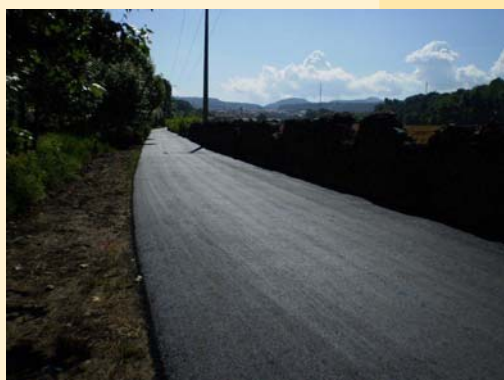
La carretera de Malars durant els treballs de millora.
