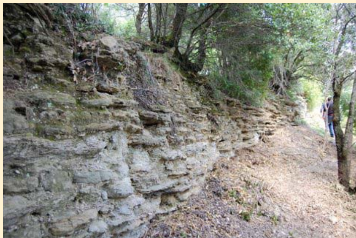
Detall de la muralla que ha estat localitzada sota la vegetació.
