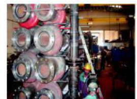
Construcción Chillers Petrogal (P)
