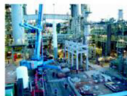
Izado en G42 Repsol A Coruña
