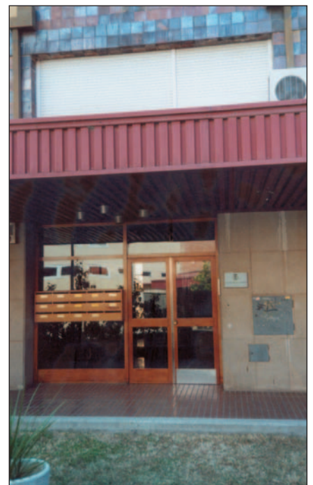
▲ Seu de la Demarcació de Girona, al carrer Santa Eugènia, 102
