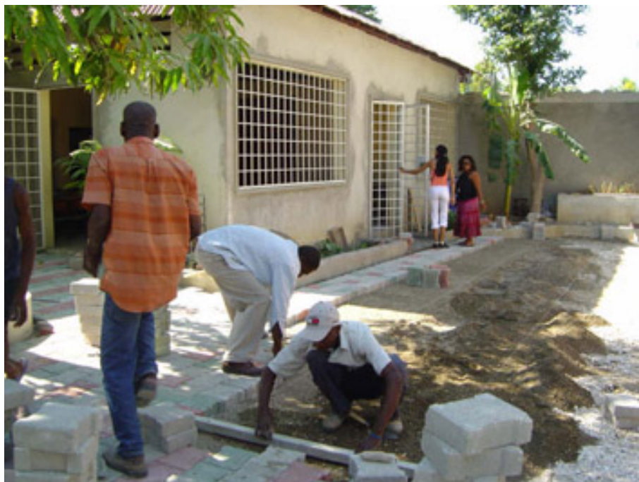
Obres de construcció de l'escola
