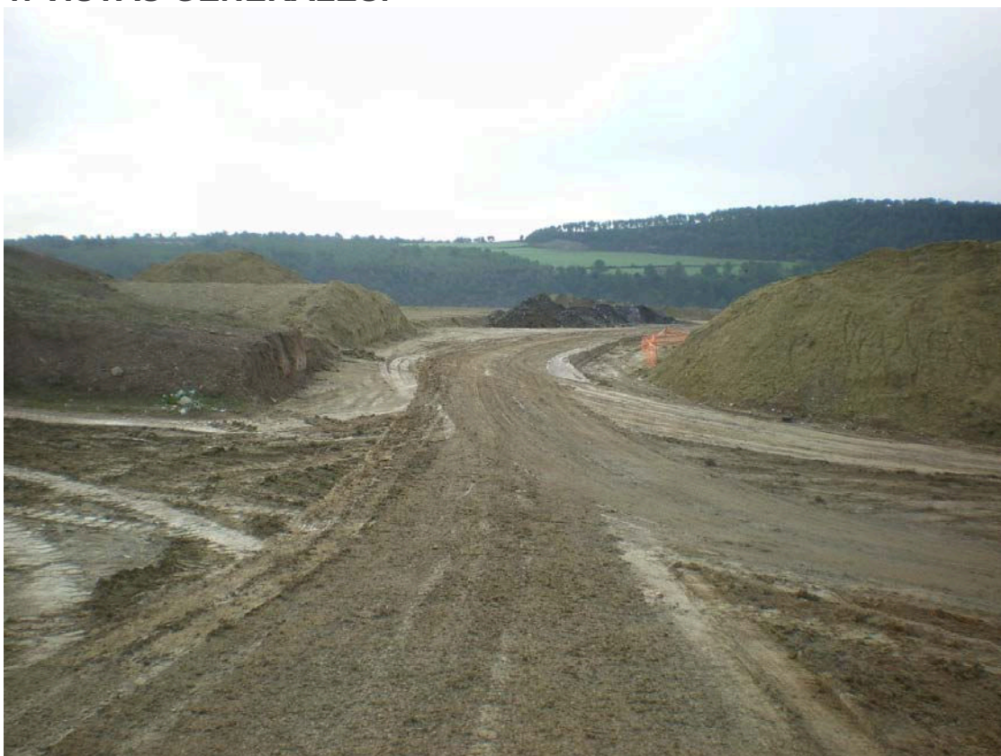
Imagen 1. Vista general de los carriles interiores del vertedero.
