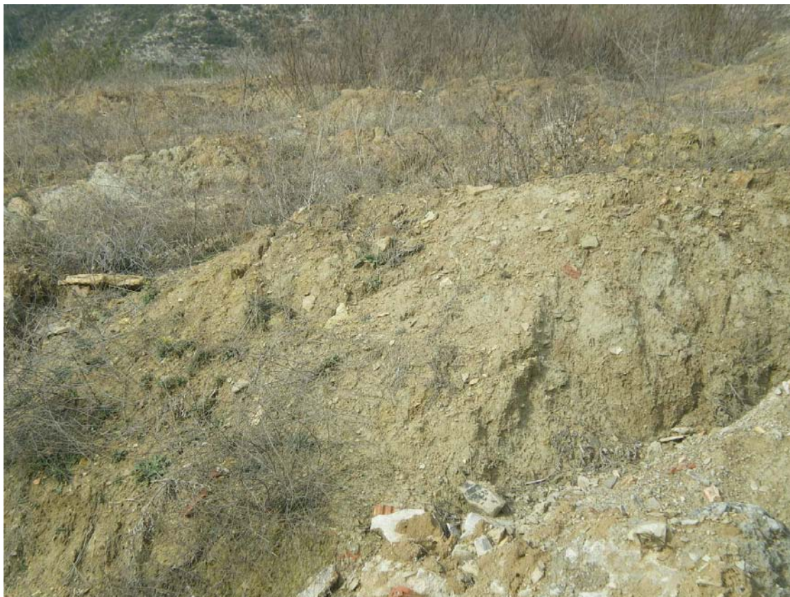
Figura 1. Vista detalle del vertedero de escombros existente en la zona objeto de estudio.
