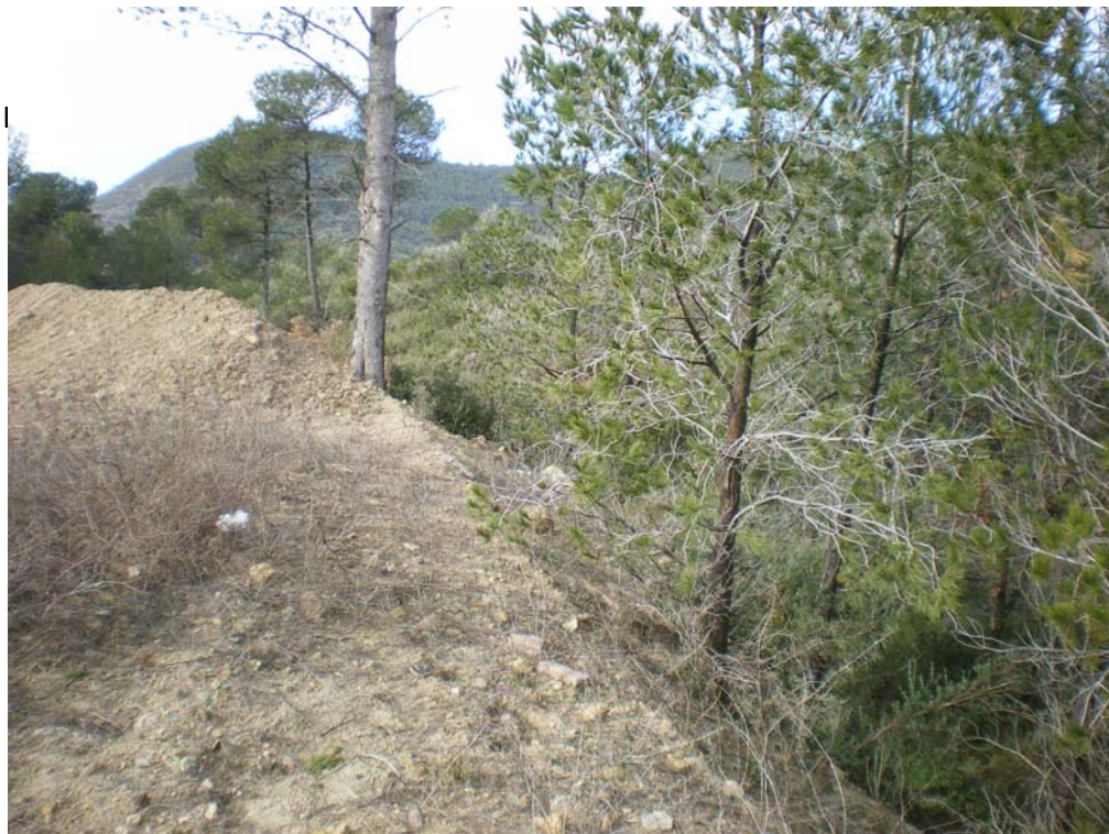
Imagen 2. Vista detalle que muestra el pinar invadido por el vertedero.
