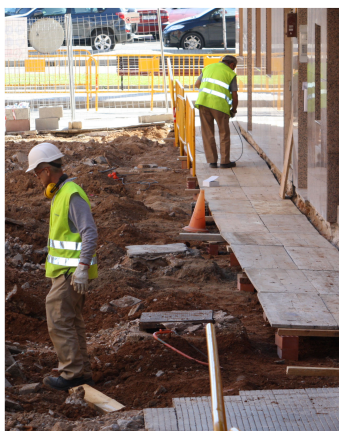
Obres de millora de la pavimentació dels carrers de la vila
