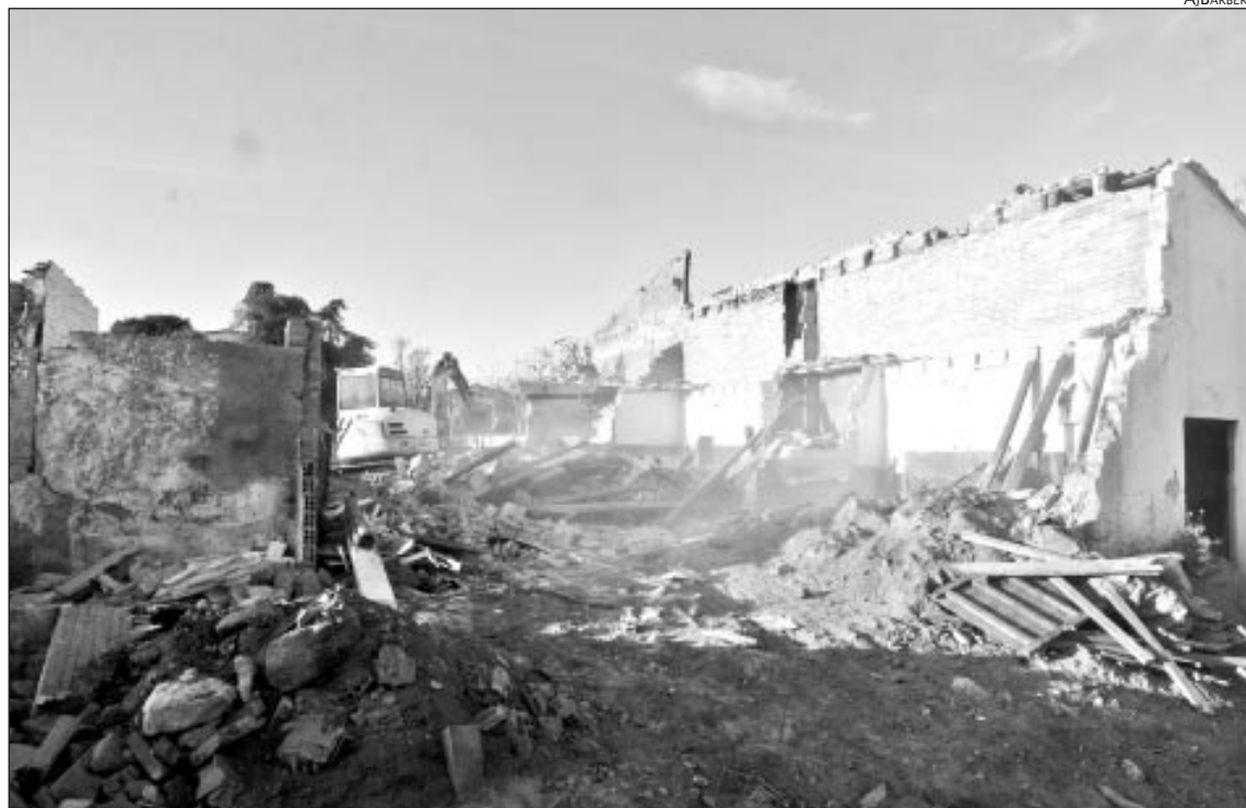
ENDERROCAMENT DE LA MASIA DE CA N'ESTEPES UBICACIÓ DE L'ESCOLA MARTA MATA
