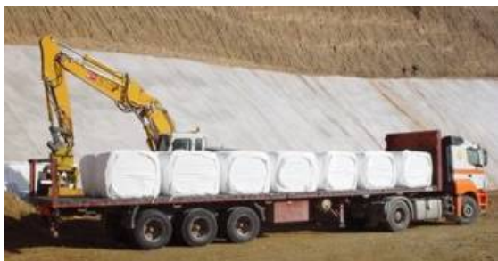
Imatges del abocador Elena actualment en funcionament.
