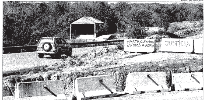
Les obres aturades a la carretera N-II, al seu pas per la demarcació de Girona.
