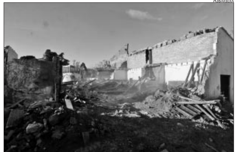
ENDERROCAMENT DE LA MASIA ON HA D'ANAR L'ESCOLA
