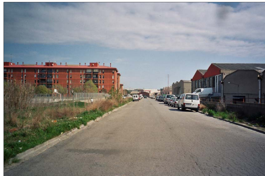
ESTAT ACTUAL DEL CARRER ARGENTONA
