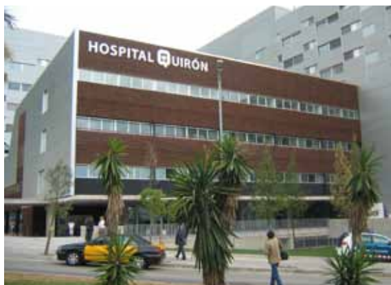
Las instalaciones de restauración del Hospital Quirón de Barcelona, cuentan con tecnología ICG
