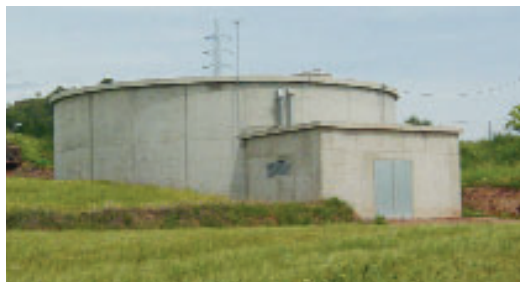
Un dels dipòsits que va entrar en funcionament l'any passat
