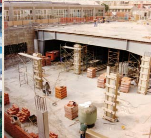
Construcció del gimnàs (1993)
