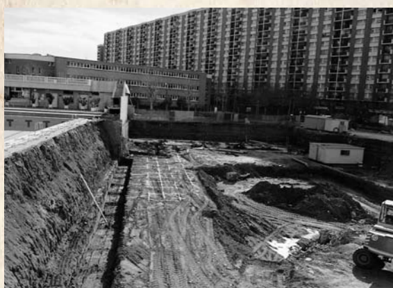
Construcció de les places de pàrquing al subsòl
