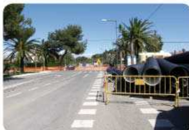
Obres de construcció del col·lector d'aigües pluvials a Vilafortuny.
