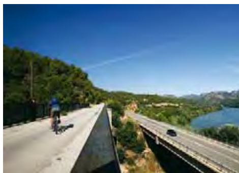
La xarxa viària és dinàmica i evoluciona al compàs del progrés tecnològic, adquirint una creixent complexitat. Antiga via fèrria de la Val de Zafan, convertida en via verda, i la nova carretera C-12, l'Eix de l'Ebre, a l'alçada de Benifallet, Baix Ebre.
