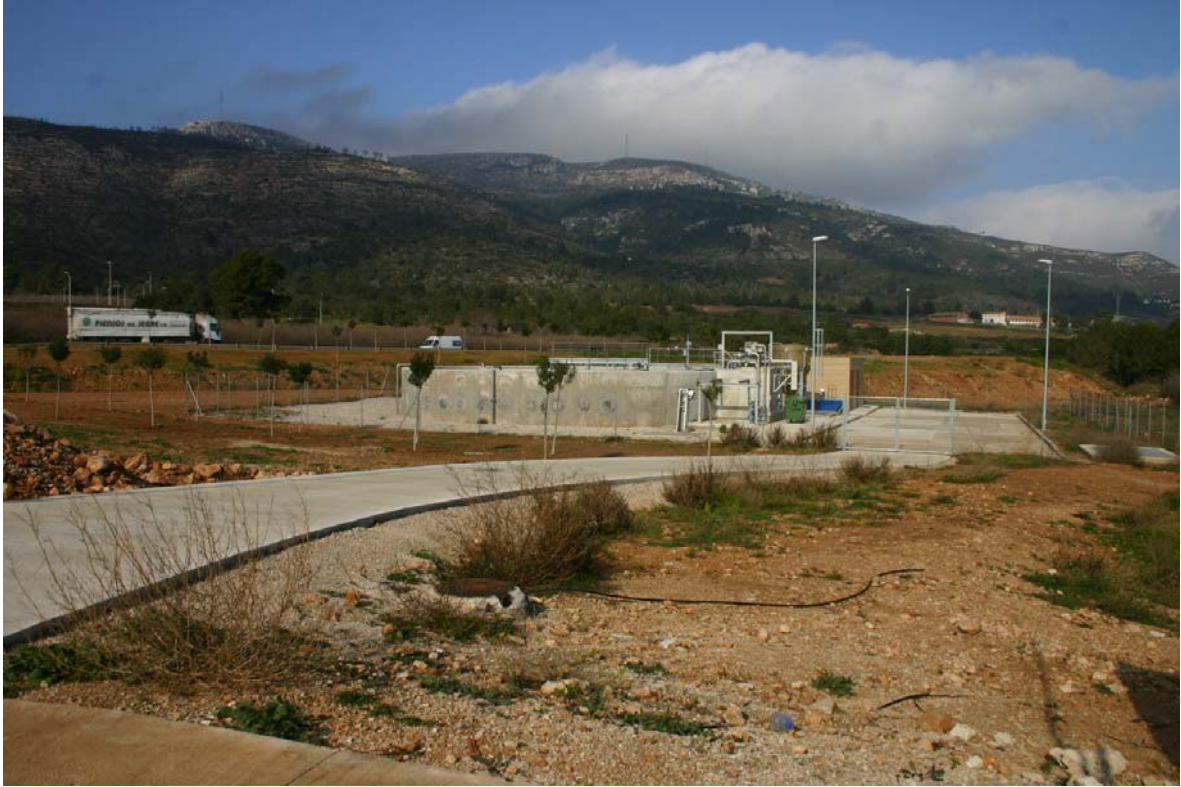
Foto. L'estació depuradora d'aigües residuals del polígon Roques Roges
