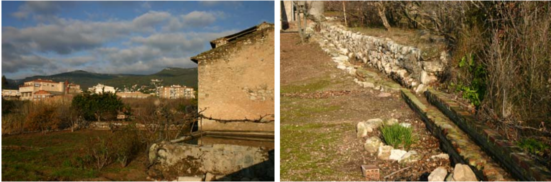
Foto. Estructura tradicional de regadiu; a l'esquerra, bassa annexa a casa agrícola, i a la dreta, conjunt de canaletes i regadores
