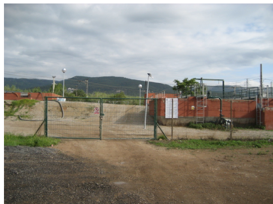
Foto. Entrada a l'EDAR d'Alcover
