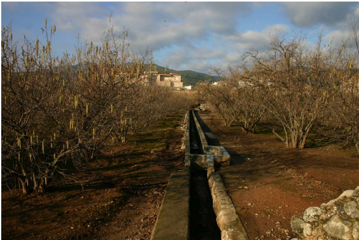
Foto. Bonic exemple de regadora en una parada d'avellaners, modernitzada – coberta de formigó – sobre l'antiga estructura de pedra
