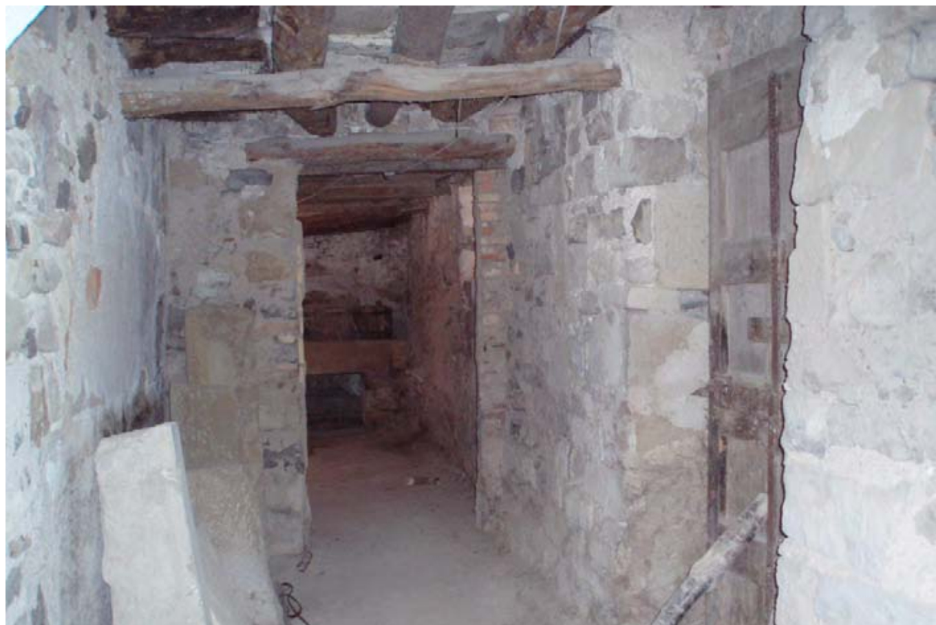
Interior de cal Valls a Ciutadilla, abans de la rehabilitació
