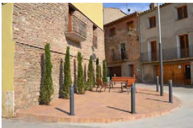
Enderroc d'edifici i urbanització de la plaça a Puigverd d'Agramunt
