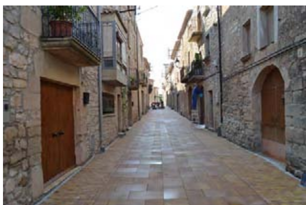
Urbanització del carrer de Catalunya a Rocallaura
