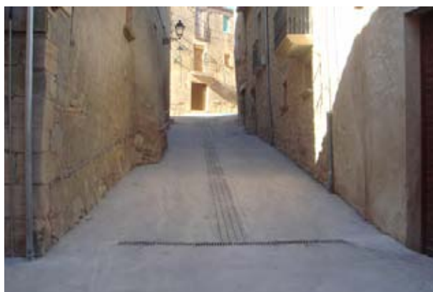
Urbanització del carrer de Vallbona als Omells de na Gaia
