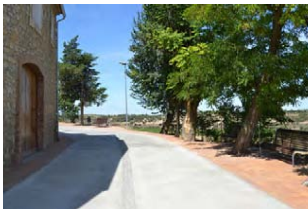
Urbanització de l'avinguda Diputació a Nalec, 2a fase
