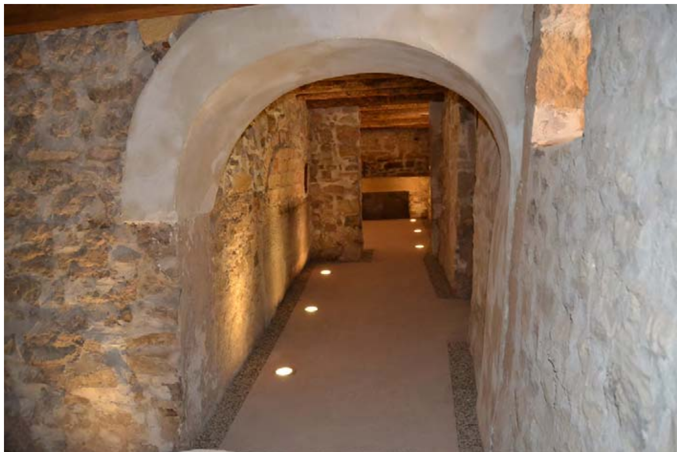
Interior de cal Valls a Ciutadilla, després de la rehabilitació
