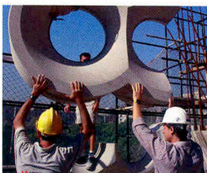
Col·locació d'una de les peces de pedra de les finestres superiors
