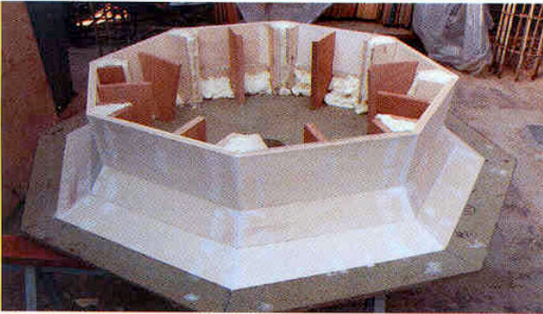
Encofrat de la segona motllura de l'òcul
