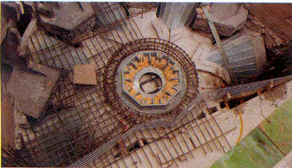
Col·locació de l'armat al damunt dels arcs i dels encofrats de fusta de la plementeria
