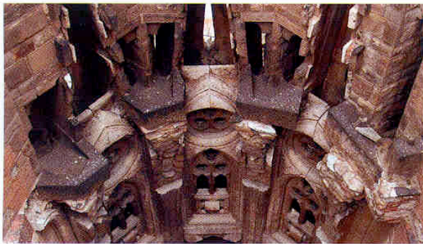
La façana interior de l'absis amb els inicis dels arcs de les capelles construïts a final del segle XIX
