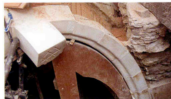
Les dovelles de l'arc situades al damunt d'un cindri de fusta
