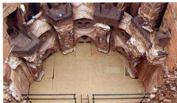
Plataforma de la bastida per a la construcció de la volta
