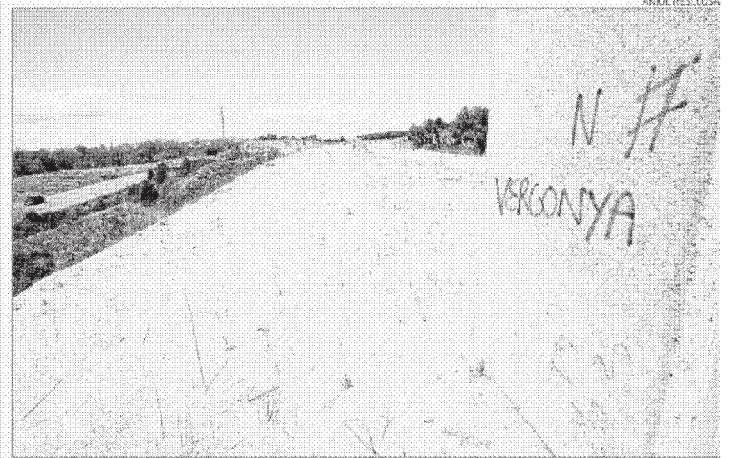
El tram d'obres de Caldes a Sils de la N-II, aturat.
