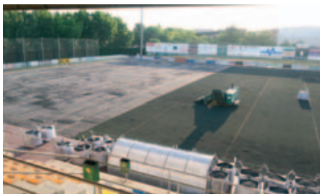
Imatge del camp de futbol en obres
