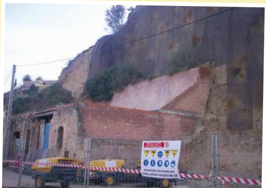
Abril 2010 - Obres del centre d'interpretació i local de la Penya
