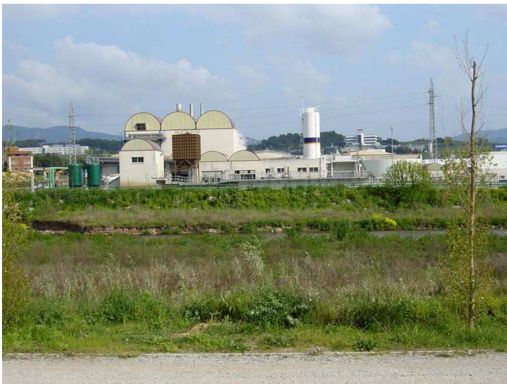
Foto 6: L'Estació Depuradora d'Aigües Residuals –EDAR- de Granollers és el principal equipament del riu Congost a Granollers.
