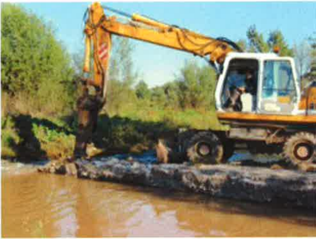
Rehabilitació fluvial: eliminació d'obstacles hidràulics i creació de passos per a peïxos. Font: Memòria final dels treballs de naturalització i creació d'hàbitats al riu Congost, 2012.
