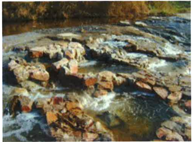
Rehabilitació fluvial: eliminació d'obstacles hidràulics i creació de passos per a peïxos. Font: Memòria final dels treballs de naturalització i creació d'hàbitats al riu Congost, 2012.
