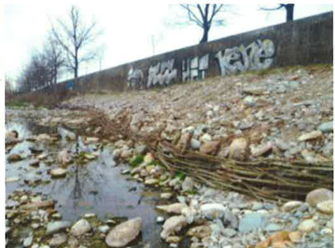
Rehabilitació fluvial: tècniques de bioenginyeria. Font: Memòria final dels treballs de naturalització i creació d'hàbitats al riu Congost, 2012.
