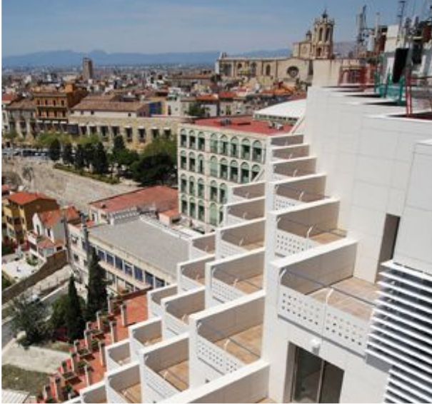
Remodelació integral de la residència per a la gent gran Mare de Déu de la Mercè de Tarragona
