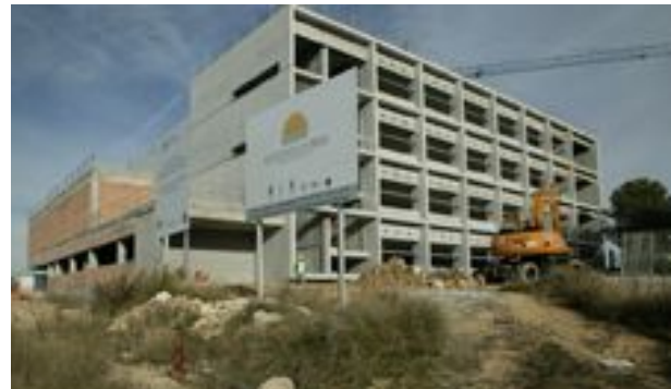
Construcció del Centre Tecnològic de la Química de Tarragona
