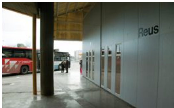
Ampliació de l'estació d'autobusos de Reus
