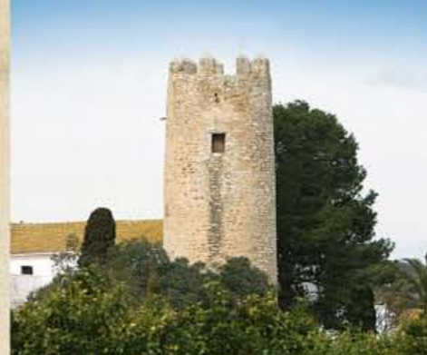
Torre de la Candela
